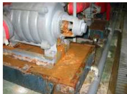
[그림 2-11] 펌프의 그랜드부 누수 모습
