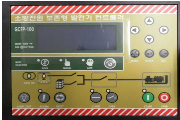
[그림 8-22] 소방전원보존형 발전기 제어장치
