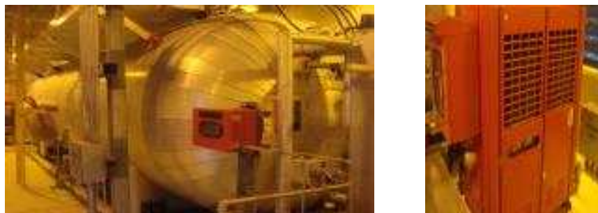
[그림 6-8] 저압식이산화탄소소화설비(저압식 약제저장탱크 및 냉동기)
