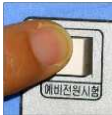
[그림 1-31] 예비전원스위치의 누름상태 표시도
