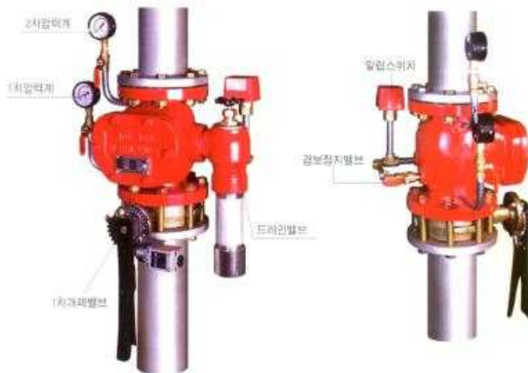
[그림 2-11] 습식 스프링클러 설비(습식 유수 검지 장치)(출처: 우당기술산업/알람밸브 취급설명서)
