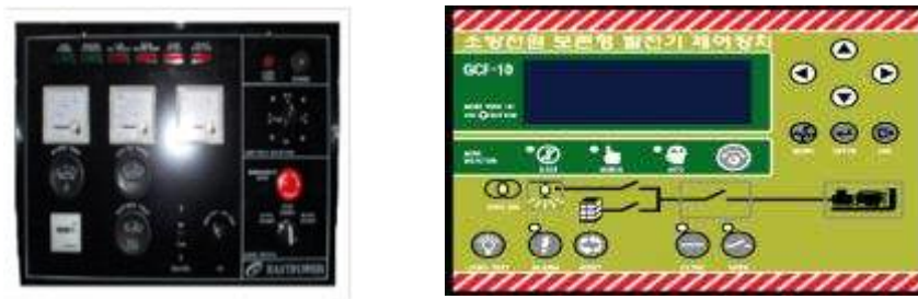
[그림 8-3] 자가발전설비의 운전반(탑재식) 및 소방전원보존형 발전기 제어장치의 예
