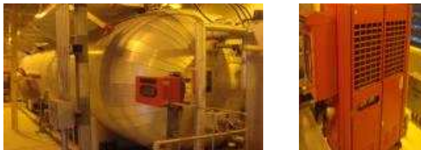
[그림 6-8] 저압식이산화탄소소화설비(저압식 약제저장탱크 및 냉동기)
