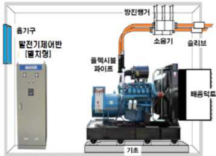
[그림 8-16] 자가발전기 별치형 제어반
