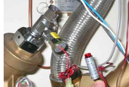
[작약식 솔레노이드밸브 및 테스트 램프]
